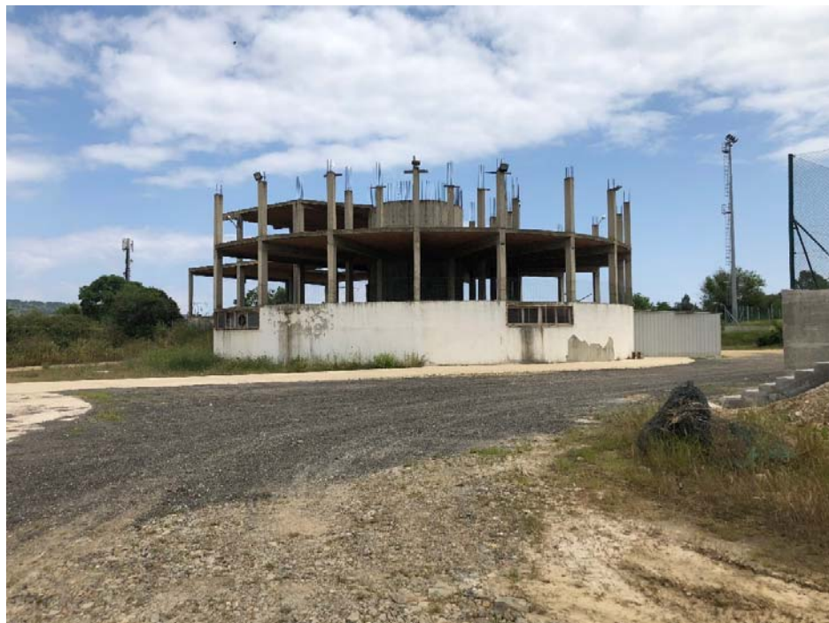
Figura 13 –Foto lato Ovest
