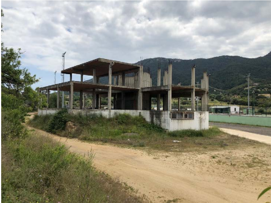
Figura 12 –Foto lato Nord-Ovest
